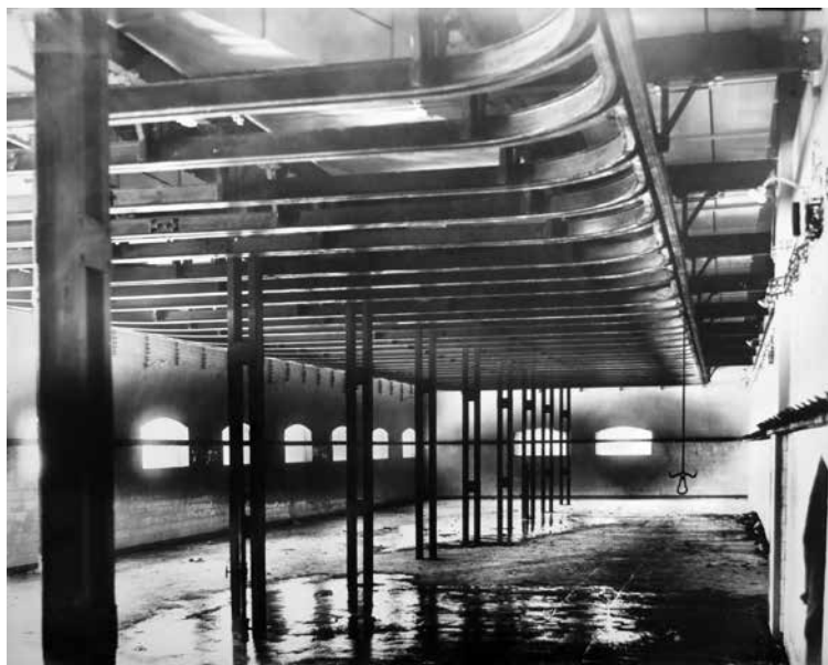
Fot. 4. Hala uboju świń (Rzeźnia na Pradze)
