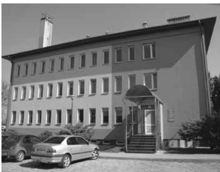
Siedziba PILW Przemyśl – po remoncie
