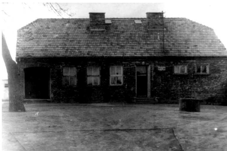
PZLZ Jedwabne na zdjęciu wykonanym 15 maja 1965 r.
